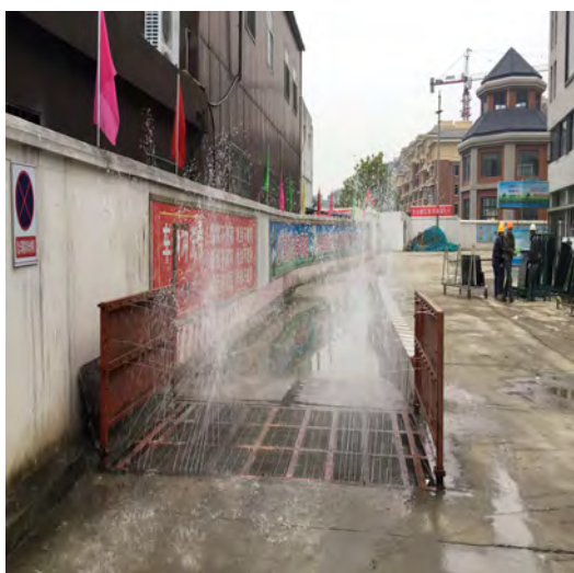
施工期进出车辆清洗
