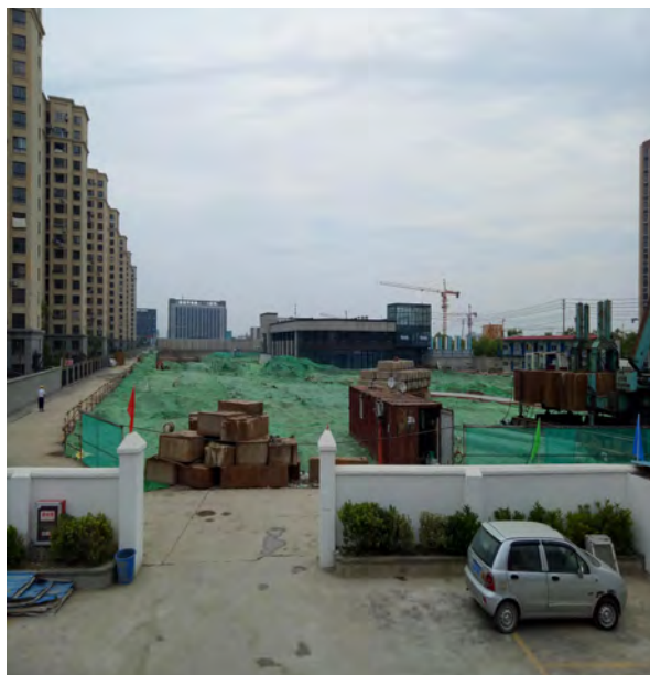
施工期裸露地面覆盖
