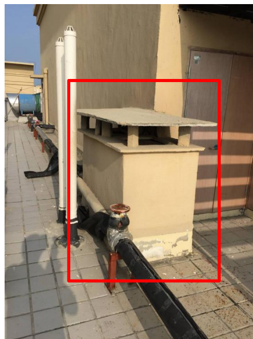
楼顶烟道排口
