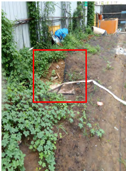
位于 C 栋西北侧化粪池
