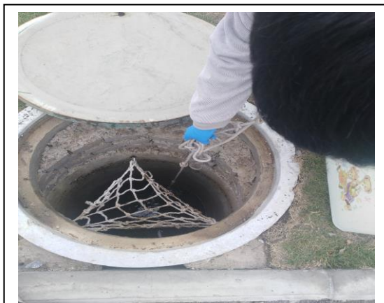
生活污水排口
