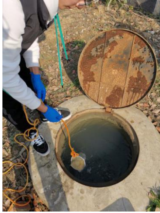
厂区污水总排口
